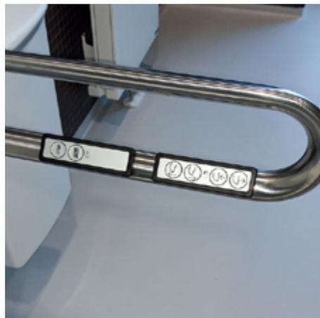
Bedienknöpfe der elektrisch höhenverstellbaren Toilette im Stützklappgriff
