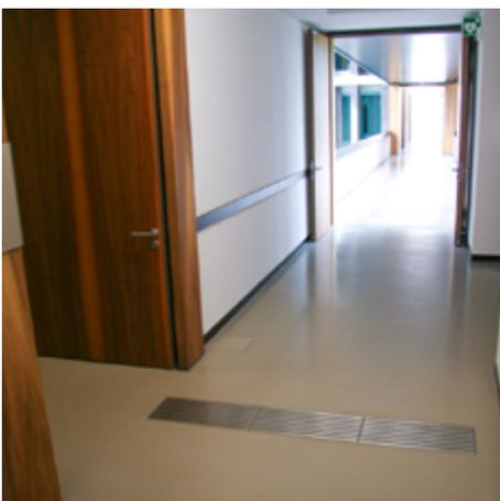
Ein Auffindestreifen aus Rippenplatten weist in einem Hauptflur auf einen abzweigenden Büroflur hin.
