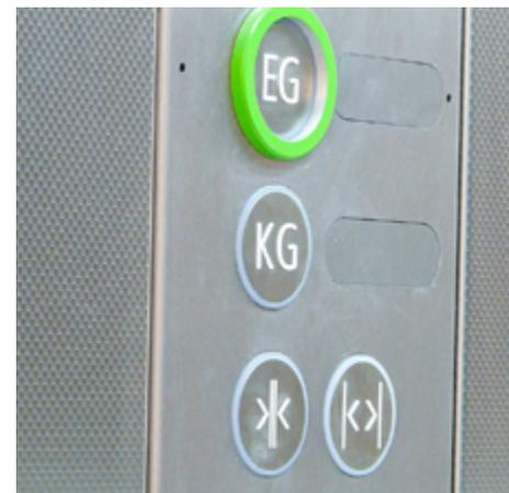
Der Taster des Ausgangsgeschosses ist taktil und optisch deutlich hervorgehoben.
