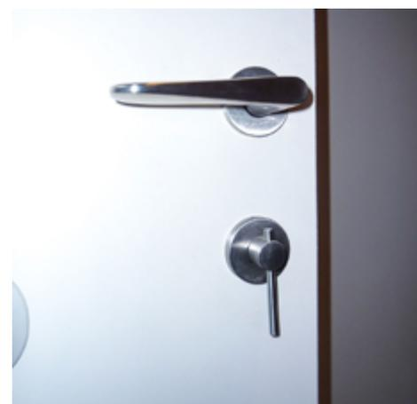
Die WC-Verriegelung mit langem Hebel ist auch bei eingeschränkter Motorik der Hand gut zu bedienen
