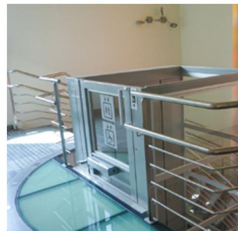
Oberer Ausstieg des Plattformaufzugs (Bild links) mit dem oben offenen Schacht
