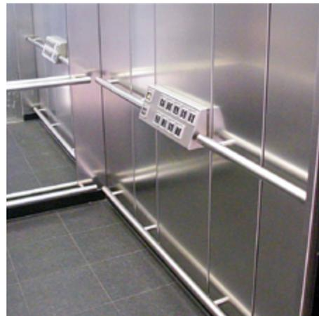
Innenansicht einer Aufzugskabine mit Bedientableau, Handlauf, Radabweiser und Spiegel gegenüber der Aufzugstür
