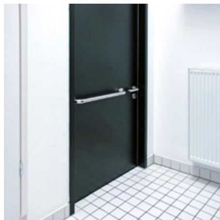
Waagerechte Zuziehstange an der Innenseite einer WC-Tür (aber Abstand zwischen Griff und Wand ist zu gering)
