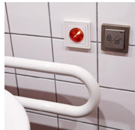
Barrierefreies WC mit Schalter für das elektrische Türschloss und roter Schließanzeige
