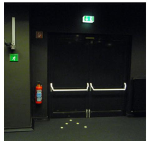
Fluchttür mit Panikriegel und nachleuchtenden Markierungspunkten in Fluchtrichtung auf dem Boden
