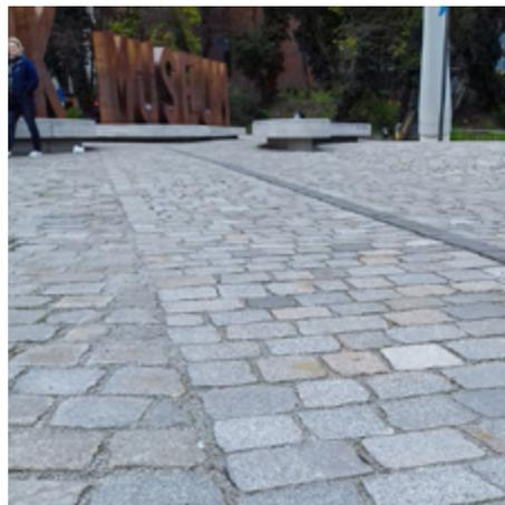
Gehstreifen mit abgeschliffenem, besser berollbarem Kopfsteinpflaster
