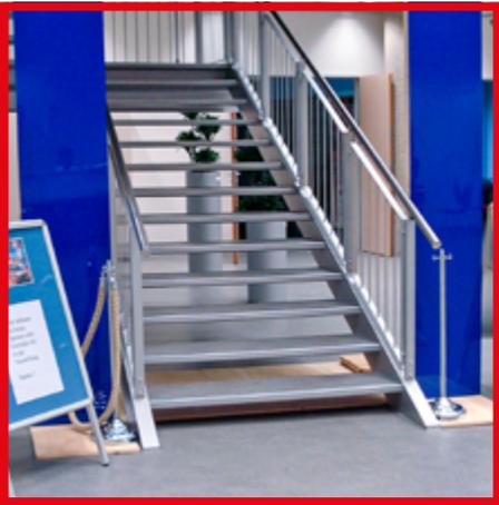
Nicht-barrierefreie offene Stahltreppe ohne Setzstufen. Der Blick durch die Stufen kann irritieren.
