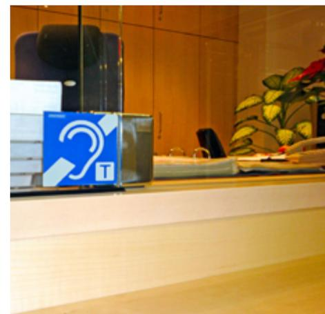
Deutliche Kennzeichnung, dass der Empfangsbereich mit einer Induktionsschleife ausgestattet ist
